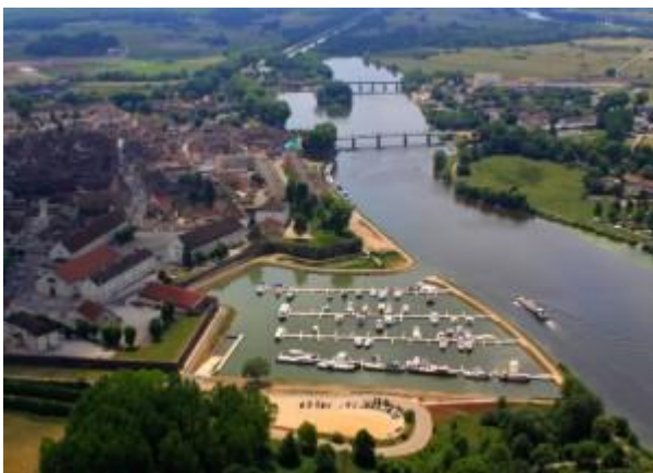
Le port d'Auxonne (Côte-d'Or) réalisé et aménagé par H2O.
