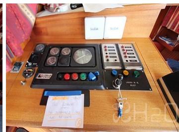
Poste de pilotage
