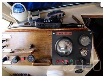
Poste de pilotage
